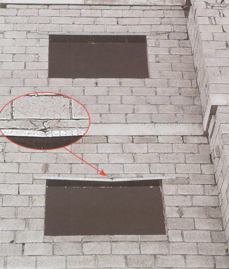
صوره لاحد المواقع تبين إنثناء و فتلان في GI والذي يسبب تساقط البلاستر مستقبلا This photo taken for one site showing the bending & twisting in GI.
