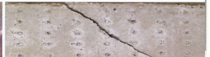
هذه الصورة تبين ضعف إلتصاق ال GI مع البلاستر وسهولة سقوطه و تشققة This Photo Shwing Plaster weakness between the GI down side with Plaster
