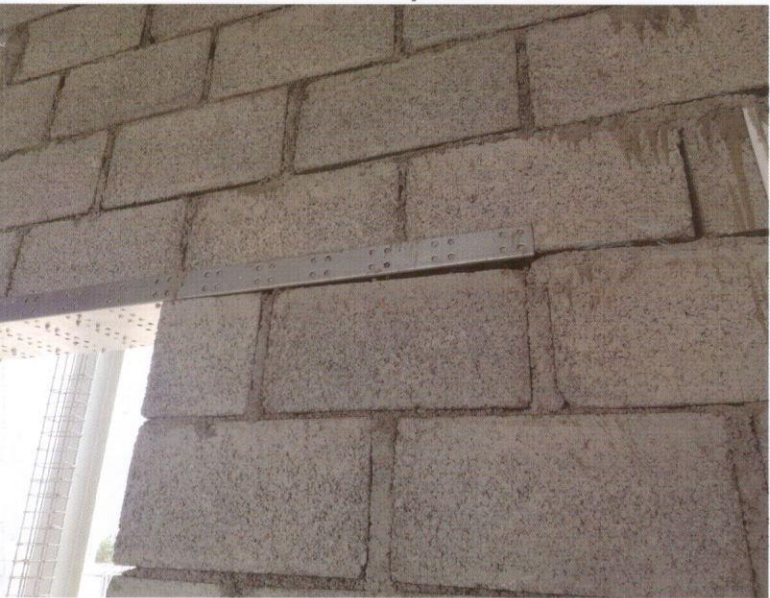
صوره لاحد المواقع تبين ارتفاع في GI من جهتين ركوب الطابوق وانثنائه مما يسبب تحطم الشباك مستقبلا This photo taken for one site showing the GI deflection and Gap one both overlap side صوره لاحد المواقع تبين إنثناء و فتلان في GI This photo taken for one site showing the bending & twisting in GI.
