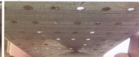
هذه الصورة تبين ضعف إلتصاق ال GI مع البلاستر وسهولة سقوطه و تشققة This Photo Shwing Plaster weakness between the GI down side with Plaster
