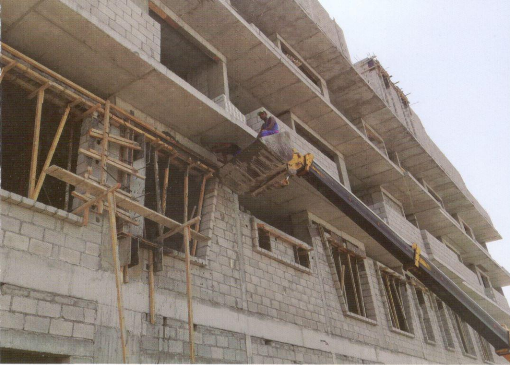
هذه الصورة تبين صب الموقع وملاحظه خطورته وتكلفته الزائده والوقت الضائع This photo showing external lintels site casting note dangrious and extra cost & time.
