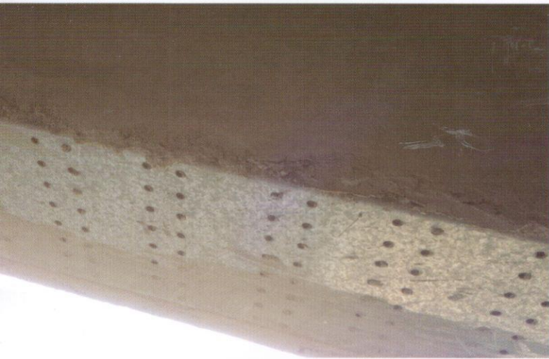
لا يلتصق البلاستر مع GI بشكل جيد لانه ذو سطح أملس مما يسبب في تكون فراغ وسقوطه بعد زمن ونفاذ الماء وصدئه The GI Has soft surface so the plaster are not sticking will so there will be a gape which case falling and rusting
