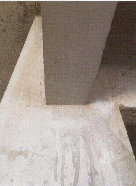
هذه الصورة تبين ضعف إلتصاق ال GI مع البلاستر وسهولة سقوطه و تشققة This Photo Shwing Plaster weakness between the GI down side with Plaster
