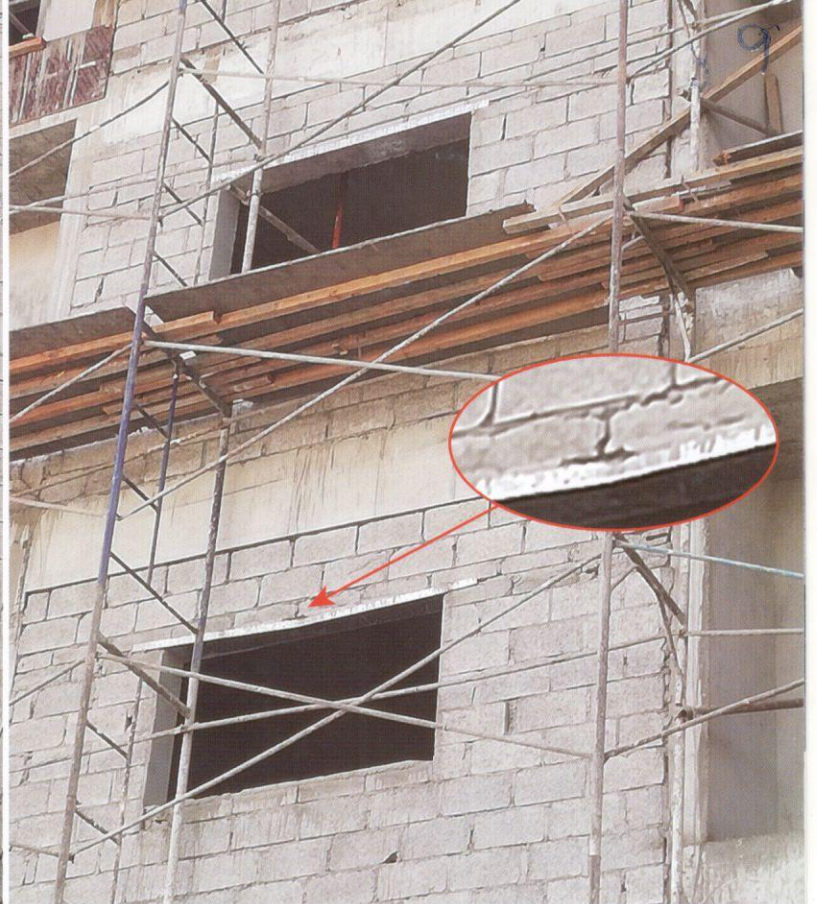
صوره لاحد المواقع تبين إنثناء و فتلان في GI والذي يسبب تساقط البلاستر مستقبلا This photo taken for one site showing the bending & twisting in GI.
