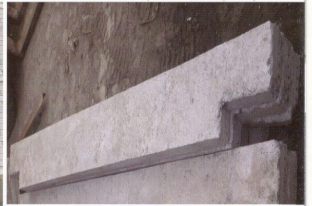
بروز 5سم او 10 سم سهل بالاعتاب الخرسانيه وغير ممكن ب GI 5 OR 10 cm extension it is not possible in GI and easy in readymade lintels
