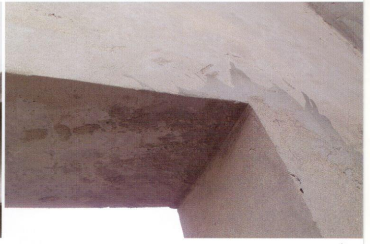
لا يلتصق البلاستر مع GI بشكل جيد لانه ذو سطح أملس مما يسبب في تكون فراغ وسقوطه بعد زمن ونفاذ الماء وصدئه The GI Has soft surface so the plaster are not sticking will so there will be a gape which case falling and rusting
